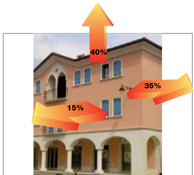
Θερμικές απώλειες περιβλήματος κτηρίου
